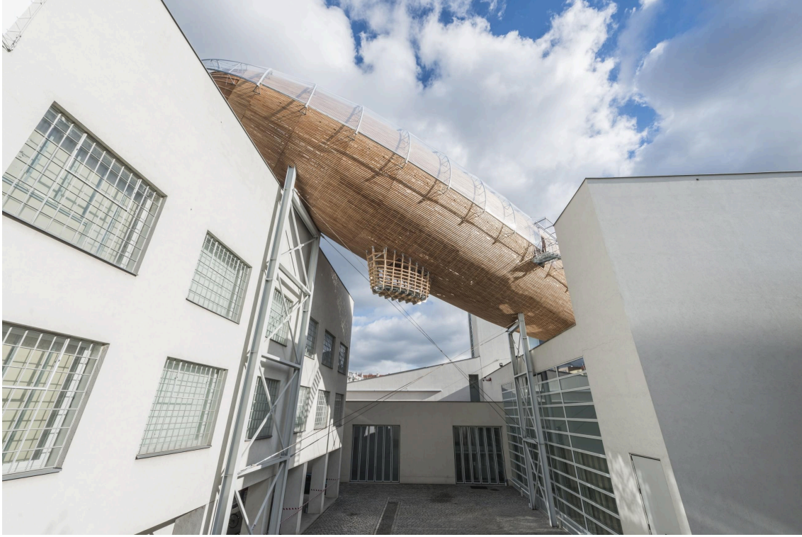
Şekil 2. Gulliver strüktürünün avlu cephesinden görünümü, parazitik yerleşimi ve çelik ayakları (Kaynak: dox.cz).
