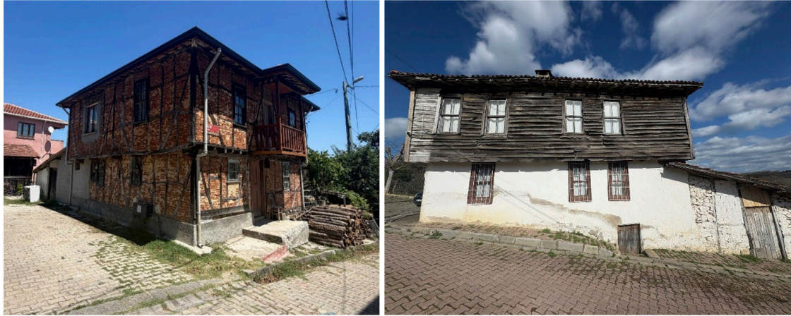
Şekil 2. Şile Meşrutiyet Mahallesi’nde Eski Yerleşimlere Ait Konutlar Not. Yazar tarafından fotoğraflanmıştır.
