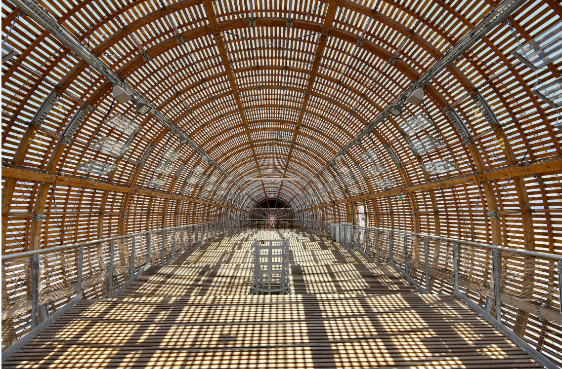
Şekil 3. Gulliver zeplininin iç mekânı; lamine ahşap kafes strüktür ve kamusal etkinlik platformu (Kaynak: dox.cz).
