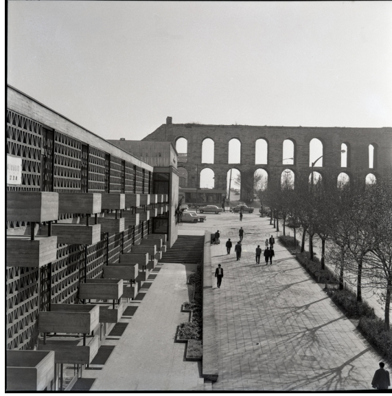
Şekil 4. İstanbul Manifaturacılar Çarşısı
